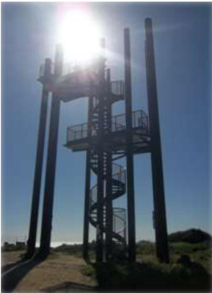
Torre mirador de hierro.
